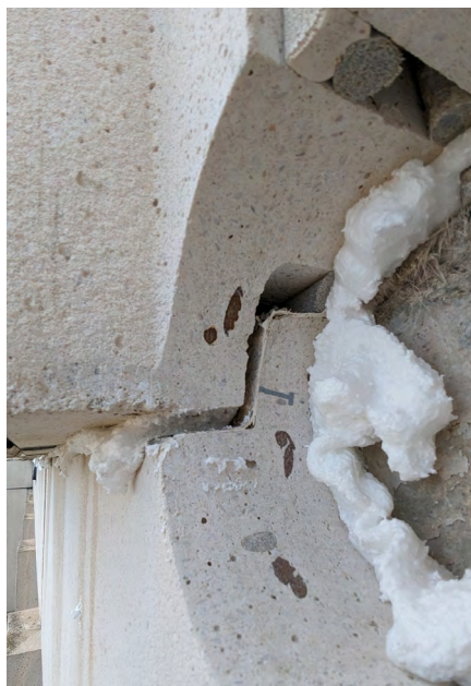
Disjointement en forme de S © Natura SCOP
