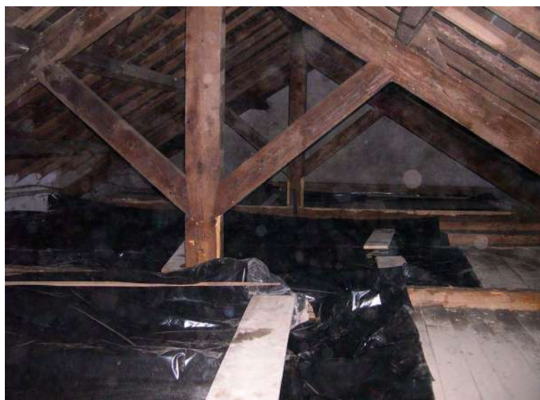
Pose d'une bâche
