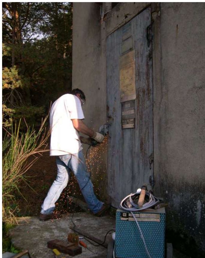
Pose d'une porte sur le transformateur
