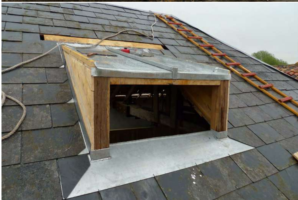
Chiroptière vue de l'extérieur
