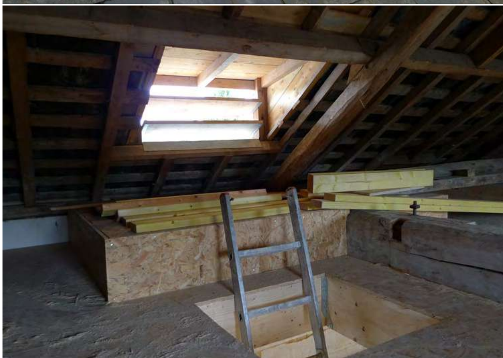
Chiroptière vue de l'intérieur avant installation du sas
