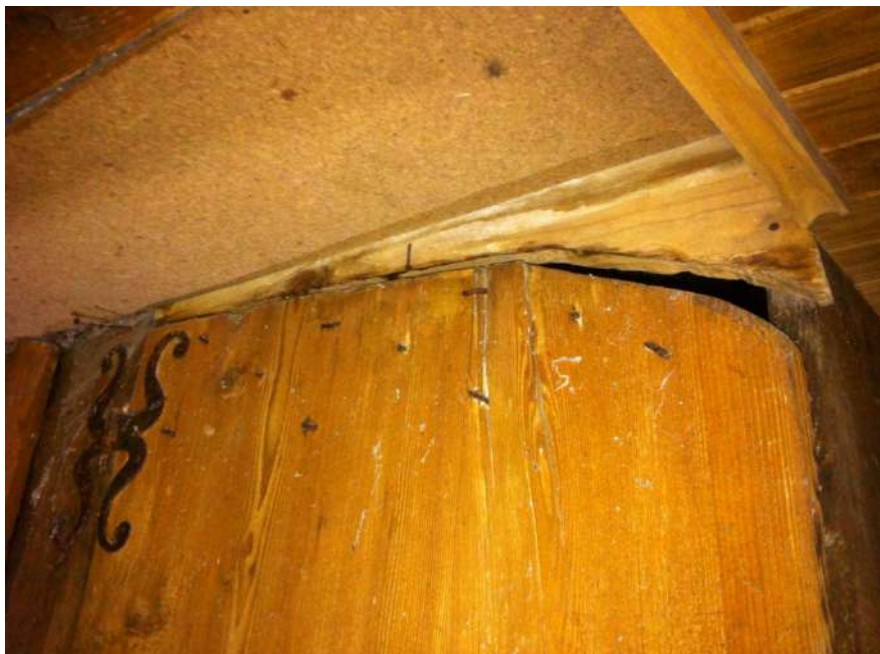
Découpe de la porte et reprise du système de fermeture
