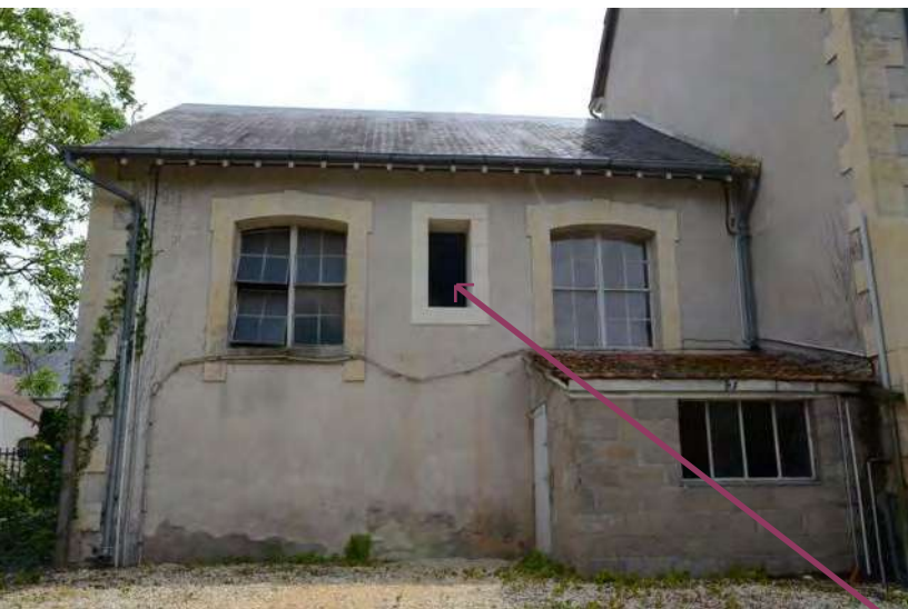
Vue de l'extérieur
