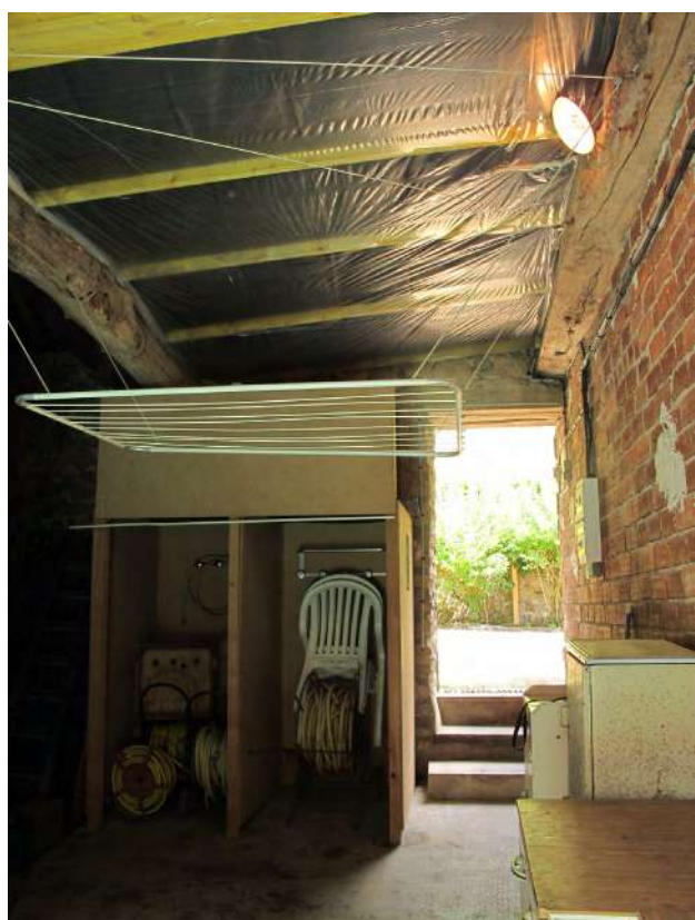
Bâche en-dessous pour dissuader les individus de s'installer au-dessous du "local piscine"
