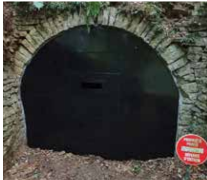
Entrée après le chantier
