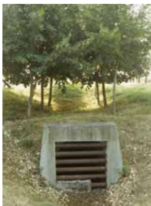
Photo 4 Grille en début du tunnel
