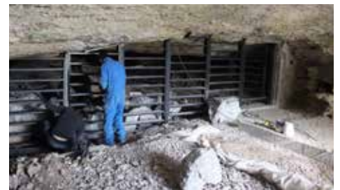
Nouvelle fermeture adaptée aux chauves-souris. Après travaux (Photos prises en février 2022)
