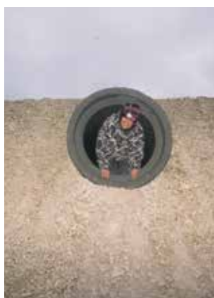
Sortie du tunnel après l'aménagement
