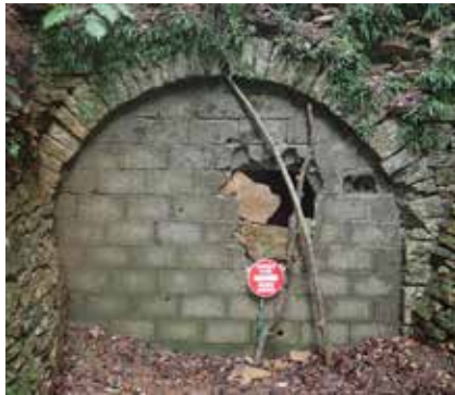
Entrée avant le chantier
