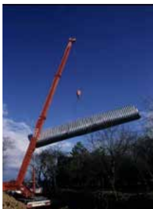
Photo 3 Pose du tunnel 1995
