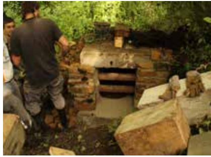
Soulèvement et calage de l'épaisse dalle béton en place sur maçonnerie (parpaings et pierres)
