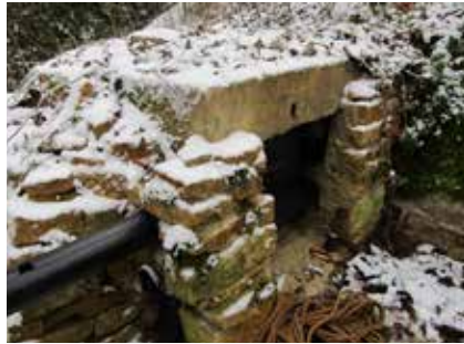
Soulèvement et calage de l'épaisse dalle béton en place sur maçonnerie (parpaings et pierres)
